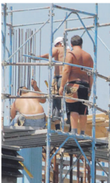
Operai al lavoro nel cantiere
